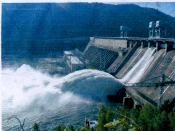
Получение электроэнергии на гидроэлектростанциях происходит методом преобразования энергии потока воды в механическую, а затем в электрическую энергию. То есть, для производства электроэнергии на ГЭС практически ничего не требуется кроме напора воды. В связи с этим, коэффициент полезного действия ГЭС достигает высоких 90-95%.
